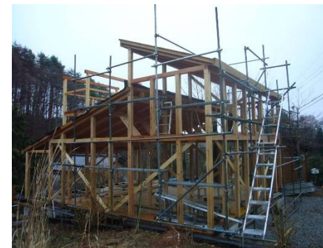
2009年4月 これまでネットオークションなどで集めておいた足場を架けます。2人で1日半くらいで完成です。この先2～3年しようするので中古の単管を購入したほうが一般的なリースよりお得です。
