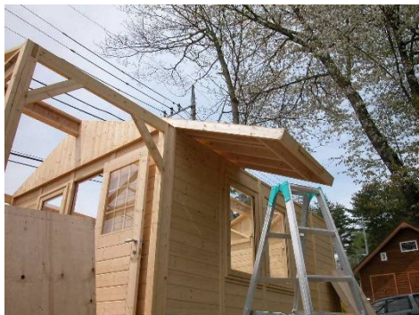
2003年5月 5日目 壁が完成したら、屋根パネルを上に掲げるのですが、これは重たくて大きいのでかなり大変。ロープを使ったりの工夫が必要です。
