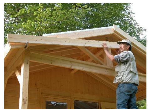
2003年5月 6日目 鼻隠しなど最終仕上げ。 一人でも作業ができるようにいろいろと工夫します。
