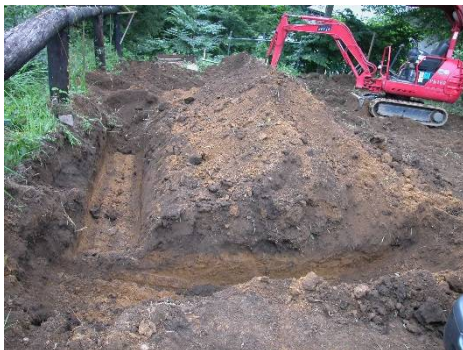
2005年7月 4月にコマツの教習所でユンボ(バックホー)の講習を終え、レンタルユンボで基礎の穴掘りです。これは面白い！是非体験の価値あります。
