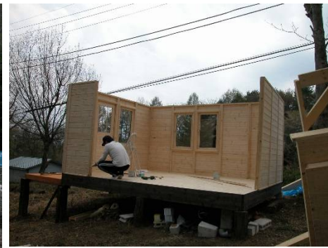
2003年5月 4日目 壁パネルをパタパタと立ち上げて床に電動ドリルで留めていくだけです。意外と早く出て、達成感の大きい一日です。
