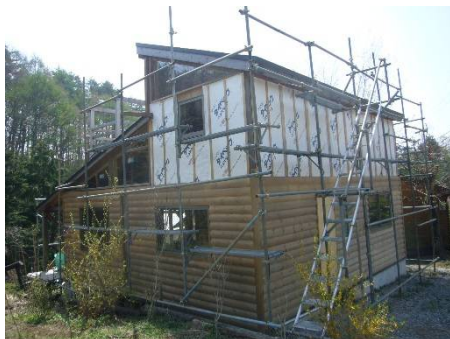
2010年5月 1階の外壁は、ログハウス調なデザインになるよう半割丸太の材料で仕上げます。一本が長いので、一人で溝を重ね合わせる作業は一苦勞です。
