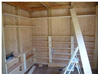
2013年8月 1階の寝室の壁は天井までの本棚。天井は有孔合板を張り、中に蛍光灯を設置して明かりが5mmの孔が見え、寝ながら星空？が見えるよう遊んでみました。
