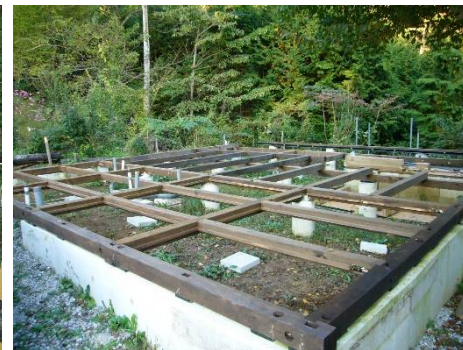
2008年10月 土台が完成するまでは一番大変。写真にわずかに写っている、給水管・排水管の埋設工事に10ヶ月。途中、別の遊びで手首骨折し半年休止。
