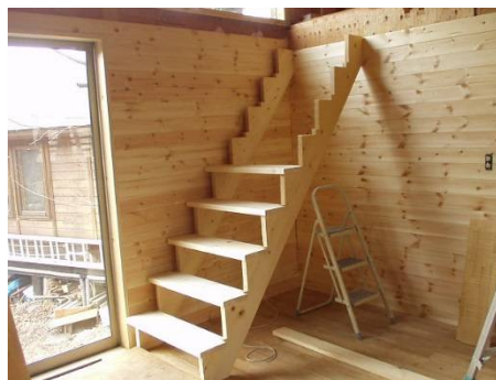
2012年6月 階段はツーバイフォの幅広材を加工します。どの大きさにしようかと寸法を決めたり、切断線を描くのに時間がかかりますが、加工組み立ては簡単。
