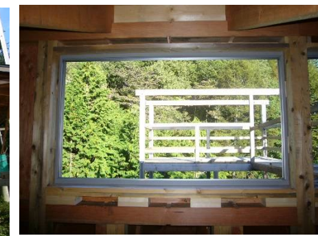
2009年10月 アルミサッシを取り付けます。取り付け枠にゆがみがあると、その調整が難しいです。サッシとガラスが入れば、雨風から室内を守るので内装作業に入れます。
