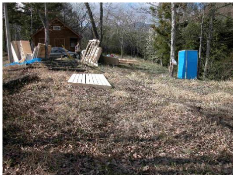
2003年5月 まず仮設トイレ(右上のブルー)を作りました。 キットハウスの部材が届いたところです。
