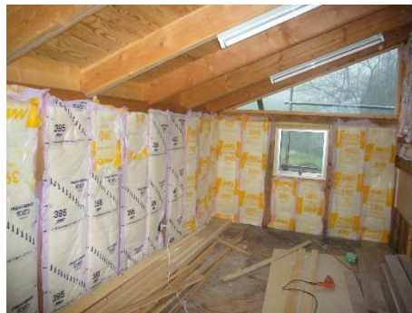
2013年5月 内壁全て100mmの厚みの断熱材を挿入しました。ガラスはもちろん全てペアガラスです。三角窓の細い頂点の枠の加工は難しいけどこだわりました。
