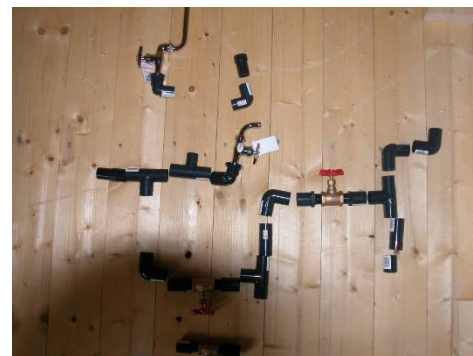
2003年9月 井戸を掘ってもらったので、給水工事です。部品が多いので、何を買ったらいのか、事前に何度も確かめます。配管作業は簡単です。
