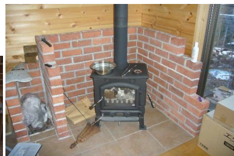
2015年1月 あこがれていた薪ストーブです。中国製で安価ですが小さいのに100kgもあり設置するのに一人大奮闘です。これでも十分機能してよく燃えます。煙突工事は難しくはありませんでしたが、レンガ積みは思ったより大変でした。外壁もそうでしたがモルタルを使用する工事は難しいです。レンガとストーブで700kgはあるため、床下の梁を補強しています。薪は木材の残材が大量にあるので当分は不自由しません。
