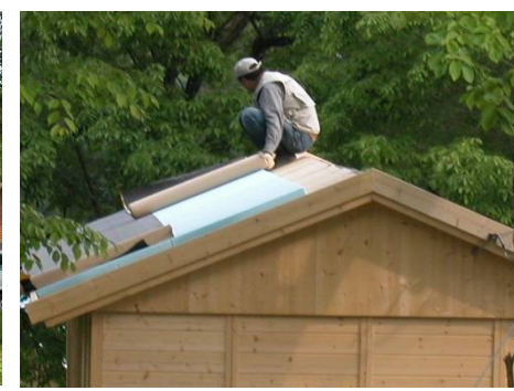
2003年6月 梅雨に備えて屋根を仕上げます。 断熱材に50mmのスタイロフォームを取り付けアスファルトシングル仕上げの屋根です。
