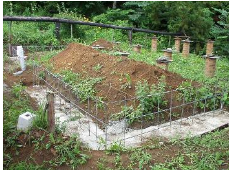
2005年8月～ 鉄筋を組み、基礎造り。鉄筋曲げの工具をオークションで購入。砂利と砂を大量に購入。一日500kgのコンクリート練り。これは大変で筋力がつきました。
