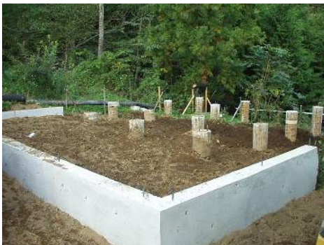
2006年10月 鉄筋を組み、コンクリートで底を固めた円形のボイド型枠の筒が1年近くの風雨で傷みだした。最後はコンクリートミキサー車とポンプ車でコンクリート打ち。
