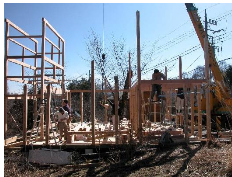
2009年3月 夜明けと同時に建て方が始まりました。4人の大工さんが奮闘。星見台から建てていきます。夕方まで作業は続きました。
