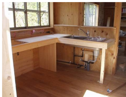
2014年3月 キッチンに電気温水器でお湯を出し、レンジは200ボルトのIHクッキングヒーター。電気配線が多く、2012年には第二種電気工事士の免許を取得し、東電に申請しました。工事店名はセルフビルドです。
