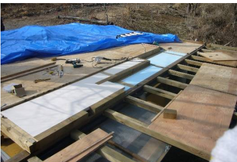
2009年2月 床には100mmと厚いスタイロフォームで断熱し、28mmの構造用合板で床を作りました。見えない床下には、電気配線がいっぱいです。土台までの工事は地味ですが一番手がかかることを実感しました。
