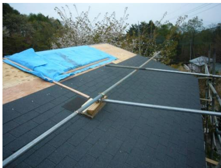
2009年5月 屋根は、仮山荘と同じくアスファルトシングル。西日で暑くならないように、厚50mmスタイロフォームと空気層を設け、強力な断熱屋根です。
