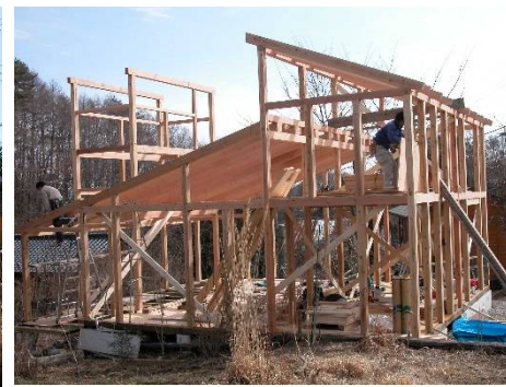
2009年3月 いつもは機械で加工したものを組み上げるので、すっぽりと組めるが、今回は手で加工したもので、久しぶりの叩き込みだと盛り上がっていました。
