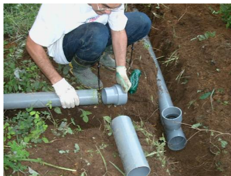
2003年9月 トイレも水洗ですから、浄化槽に配水管をつなげる工事をします。勾配をうまくとりながらの穴を掘っての配管工事は意外と大変です。
