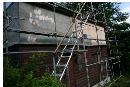
2012年6月 2階の外壁は、左官作業を行いたいという興味から、珪藻土にしました。珪藻土塗りは簡単でしたが、下地のモルタル塗りは難しいですね。
