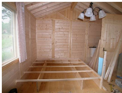
2003年8月 電気も取り付け内装工事。ここまでくれば、外のトイレを使用しながら、寝泊りができるので、土日での作業は順調にはかかります。
