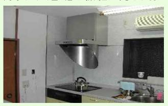
ある大手メーカーが東京ガスと開発したものが下記の写真のようなスタイリッシュのキッチンで、ヒーターのそばの吸気口より油煙を吸い込み中で油分等を浄化してはき出します。しかし、空気を浄化して循環するだけですから二オイや煙には効果がありますが、水蒸気は水蒸気は除去できませんので、空調機・補助換気扇などとの併用が必要です。
