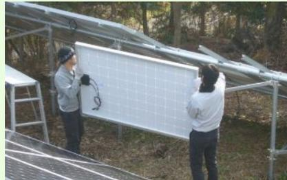
架台ができればパネルは1日程度で設置できます。架台工事作業は一人でもできますが、パネル(約20kg)を架台載せるのは一人では無理で最
